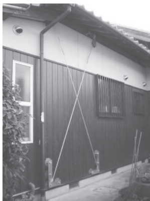
ウッドピタブレース設置状況
