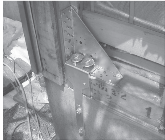
外壁側出隅柱脚部への設置例
