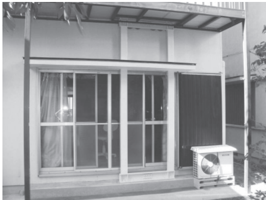
ウッドピタフレーム設置状況
