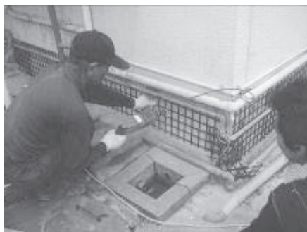
写真1 施工状況1 (FRPグリッド取付)
