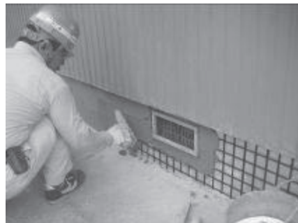
写真2 施工状況2 (PCM塗布)
