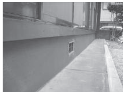
写真3 施工状況3 (施工完了)
