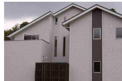
〈タイル仕上げ〉
